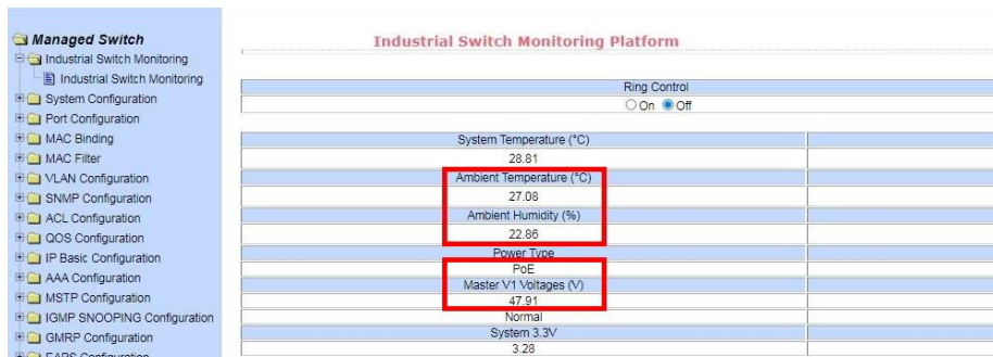
Рис.7 Контроль напряжения питания, параметров температуры/влажности окружающей среды через Web-интерфейс коммутатора
